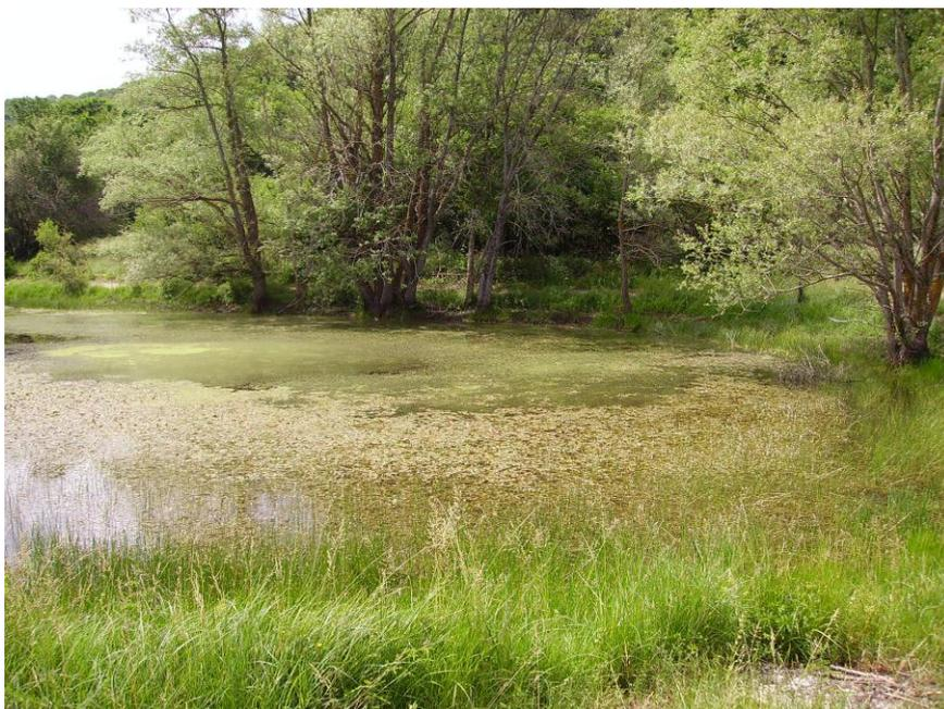
Sono dispositivi che possono fornire attenuazioni al rischio idraulico e trattamenti per migliorare la qualità delle acque. Alternano stagni poco profondi a zone umide paludose ricoperte quasi interamente da vegetazione acquatica. Catturano e detengono i flussi per lunghi periodi permettendo una accurata sedimentazione, facilitando i processi di fitodepurazione in grado di rimuovere i contaminanti, apportando significativi benefici estetici ed ecologici.
