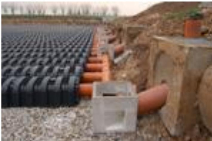
Sono dispositivi con un'alta capacità di detenzione che possono essere usati per creare sotto il terreno strutture in grado di contenere grandi quantità d'acqua o di permettere l'infiltrazione nel terreno
